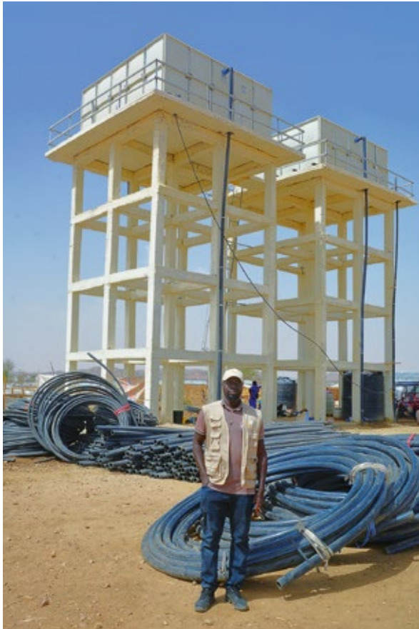
Abdelkerim vid en av vattenreservoarerna i flyktinglägret Meche, där arbetet med grävning och utläggning av vattenledningar pågår. PE-slangarna har just anlänt från N'Djamena, fem dagsresor bort. Reservoaren rymmer 100 000 liter och förser tusentals flyktingar med vatten varje dag.
