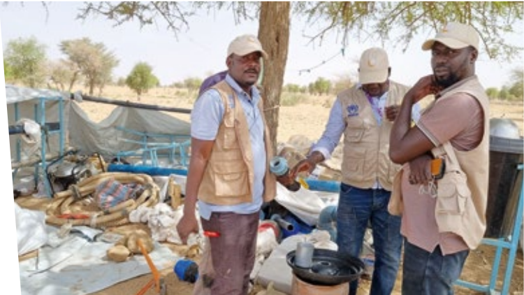
Mahamat Nour, Wilba och Abdelkerim vid ett tillfälligt lager av rördelar till byggnationen av vattensystemet i Meche camp.
