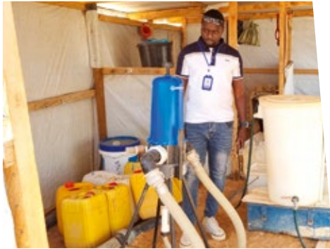
Abdelkerim vid en av klordoseringsstationerna i Aboutengués flyktingläger. Vattnet från brunnarna är i normalfallet rent och fritt från bakterier men då flyktingarna hämtar vatten i plastdunkar finns risk att det förorenas där. Därför behöver vattnet kloreras för att minska risken för sjukdom.
